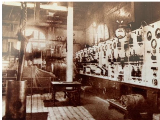
De elektrische centrale van Rijkswerf Willemsoord
