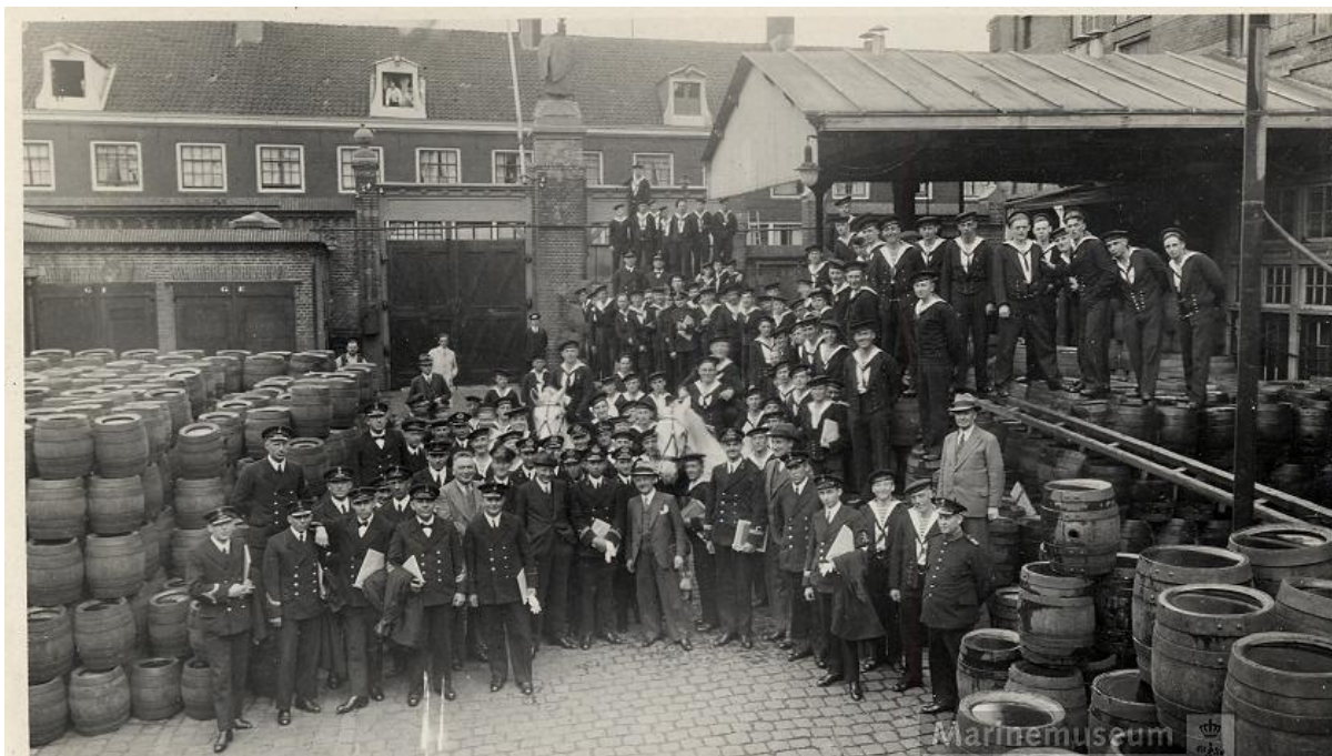
Opslagplaats voor watervaten op het Marine Etablissement Amsterdam, ca. 1930 Foto Marinemuseum
