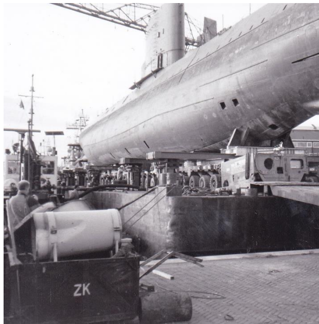
Zicht op het aandrijfgedeelte van de voorste twee transportwagens tijdens het aan-brengen onder de dwarsbalken door de portalen.
