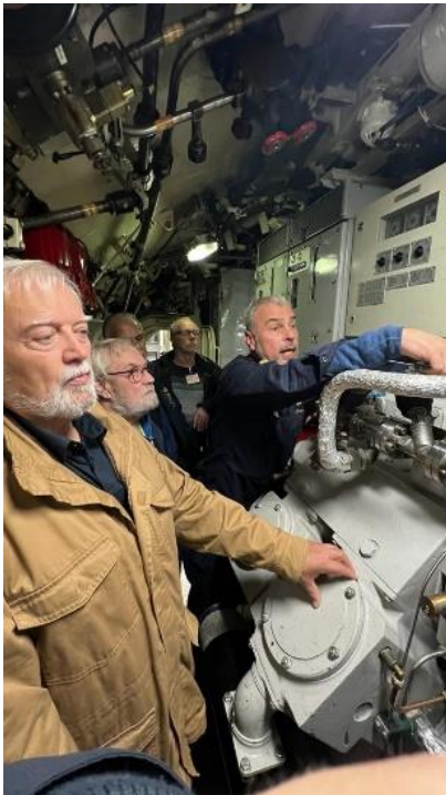
UITLEG IN DE MACHINEKAMER
